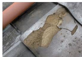
屋根材の基材に浸み込んだ雨水が凍り発生してしまう「凍害現象」に強い商品です。
